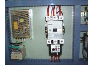
siemensAC contactor
